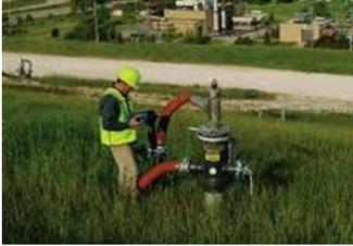
La revisión de la red de tuberías con medidores especiales es una labor diaria a realizarse con la finalidad de identificar posibles fugas, las cuales pudieran causar por acumulación de biogás potenciales explosiones (ver recuadro página anterior). Otra acción similar es el monitoreo del quemador de biogás o bien de las plantas generadoras de electricidad.
